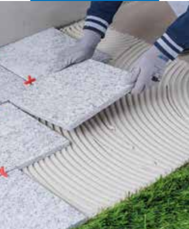
Εφαρμογή φυσικών λίθων σε εξωτερικούς χώρους
