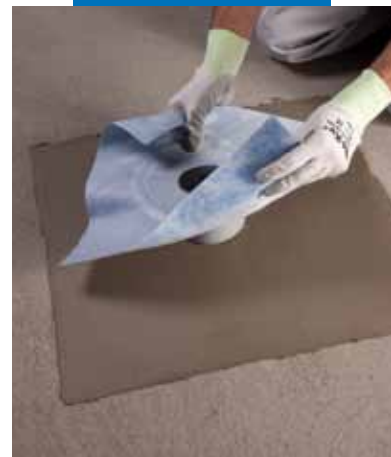
Εφαρμογή του Drain Vertical στο Mapelastic
