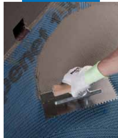
Τοποθέτηση Mapelastic στο Mapeket 150
