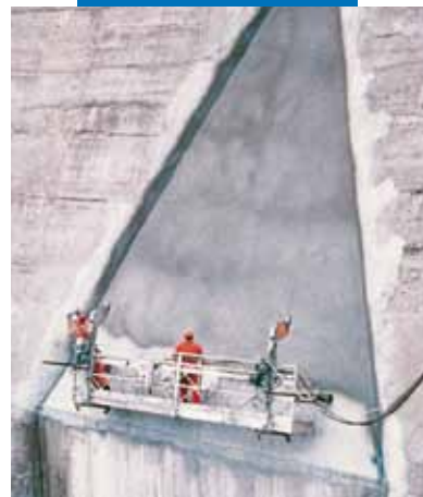
Παράδειγμα εφαρμογής Mapelastic με ψεκασμό σε φράγμα
