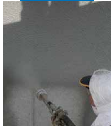
Παράδειγμα εφαρμογής Mapelastic με ψεκασμό σε αυτοκινητόδρομο
