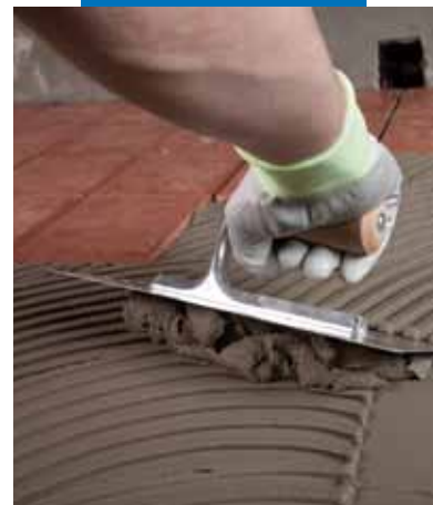
Τοποθέτηση Graniparid σε ταρατσα στεγανωμένη με Mapelastic
